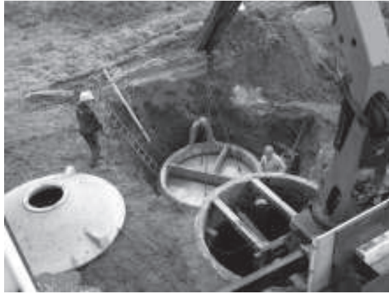
Versetzen der biologischen Reinigungsstufe
