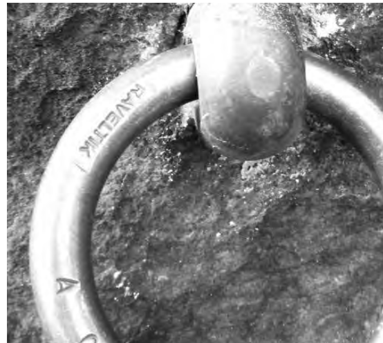
Typ „A“ Ring: Hier ist der Schaft zu kurz (Länge nur 150 mm).
