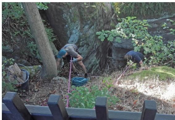
Müllberäumung unter der Brandbaude
