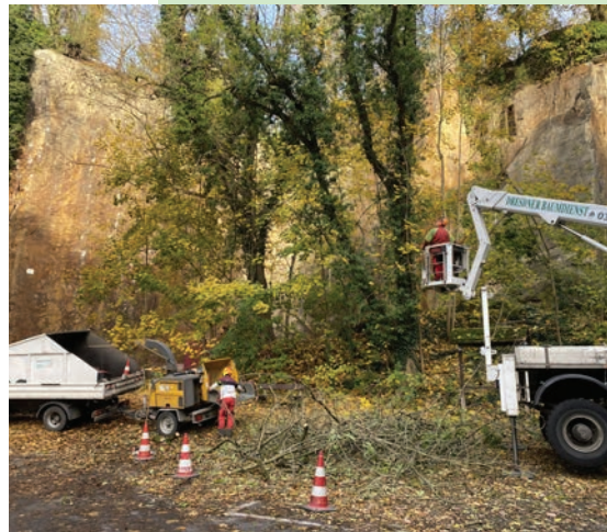
Bild S. 7: Verkehrssicherungsarbeiten der KTA in den Klettergärten und an den Hütten – Im Zeitraum Oktober/ November wurden durch die KTA in den Klettergärten Cunnersdorf, Liebenthal und der Hütte Bielatal umfassende Verkehrssicherungsarbeiten durchgeführt. Insgesamt wurden ca. 250 Bäume begutachtet und beurteilt, um die Sicherheit auf anliegenden Straßen und Wegen sowie auf den jeweiligen Grundstücken zu gewährleisten. Insgesamt wurden an 46 Bäumen Arbeiten durchgeführt. Foto KTA
