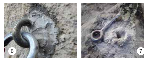
Bild 8: herausstehende Öse Schlechte Installation. Der Kleber ist zu schnell ausgehärtet und die Öse nicht mehr bis Anschlag reingegangen. Der Fels sieht unten auch nicht ausgespitzt aus. Die Öse an sich ist eine KTA-Normöse.
