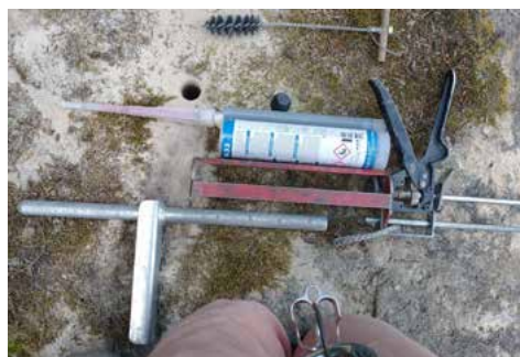
Einbau einer Gipfelbuchstütze, Foto: Frank Wehner
