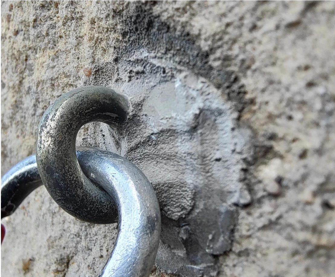
Bild 6: verbaute Gerüstöse
