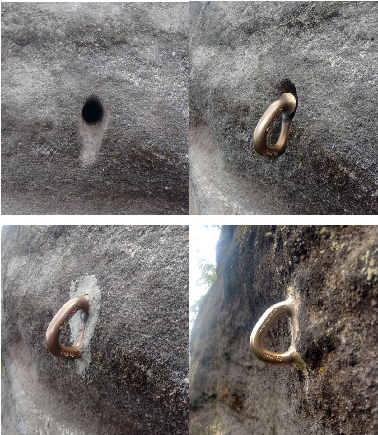
Bild 17: gutes Beispiel KTA-Normöse
