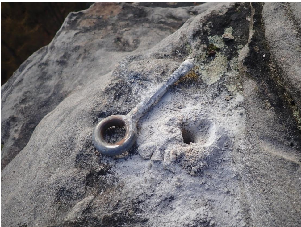
Bild 7: ausgebohrte Gerüstöse
