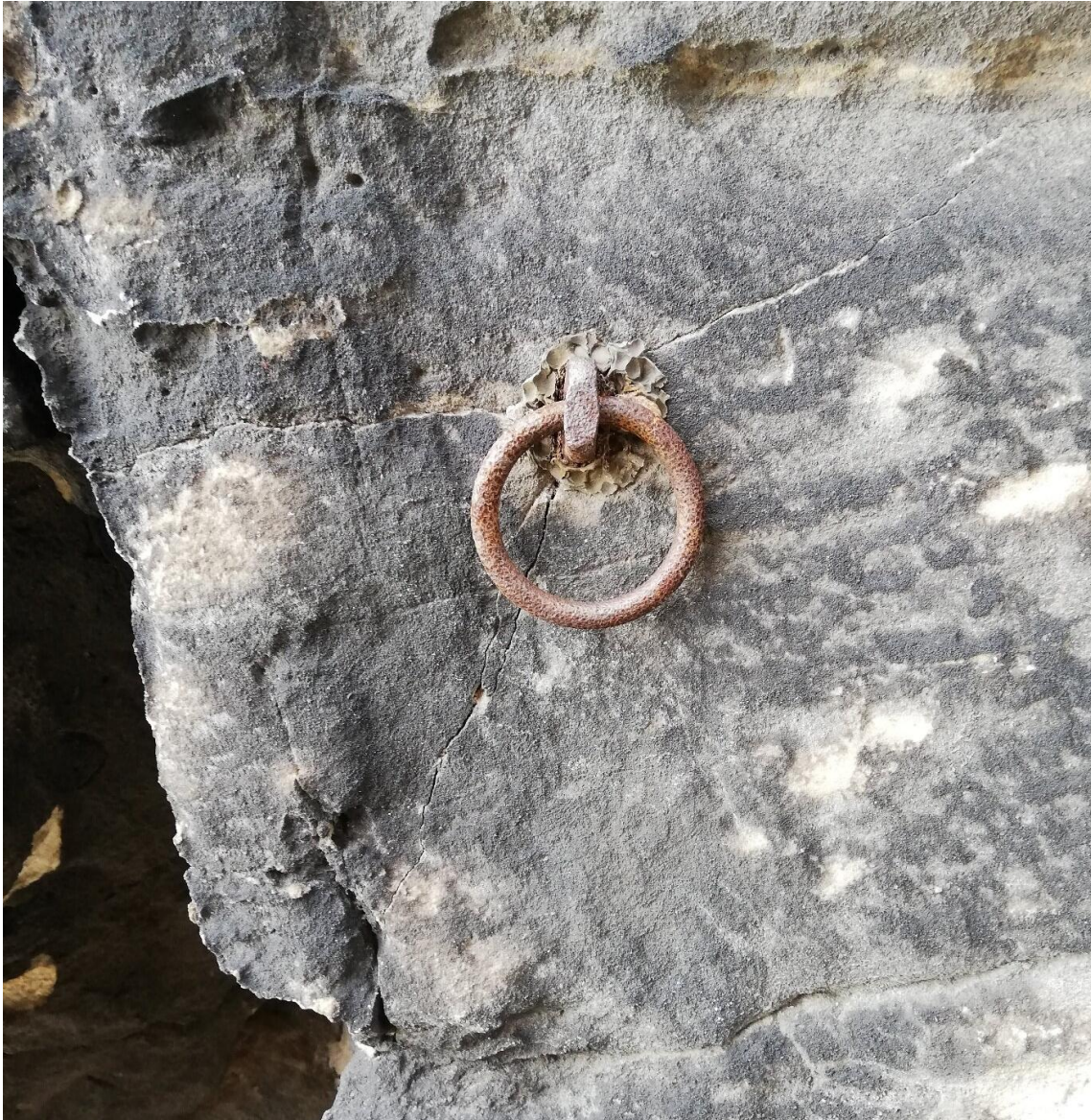
Bild 12: stark gerissener Fels
