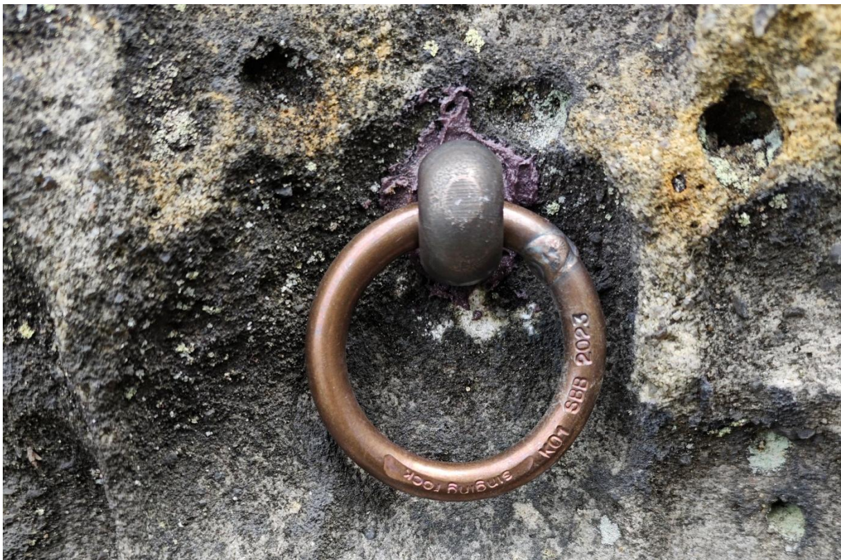
Bild 3: Installierter KTA-Edelstahlring
