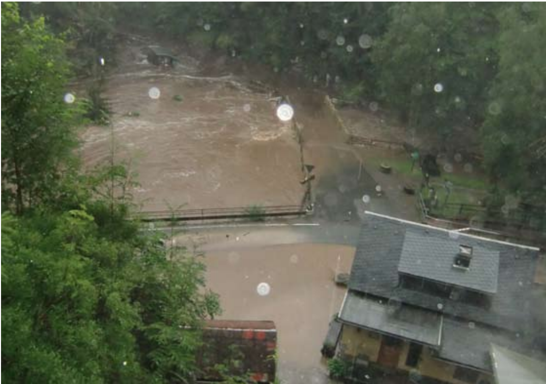
Blick oberhalb der Neumannmühle auf die Kirnitzsch und die überschwemmte Brücke und den Parkplatz. Die Insassen der Neumannmühle brachten sich über den Berg in Sicherheit. (Foto: Markus Galle, Neumannmühle)
