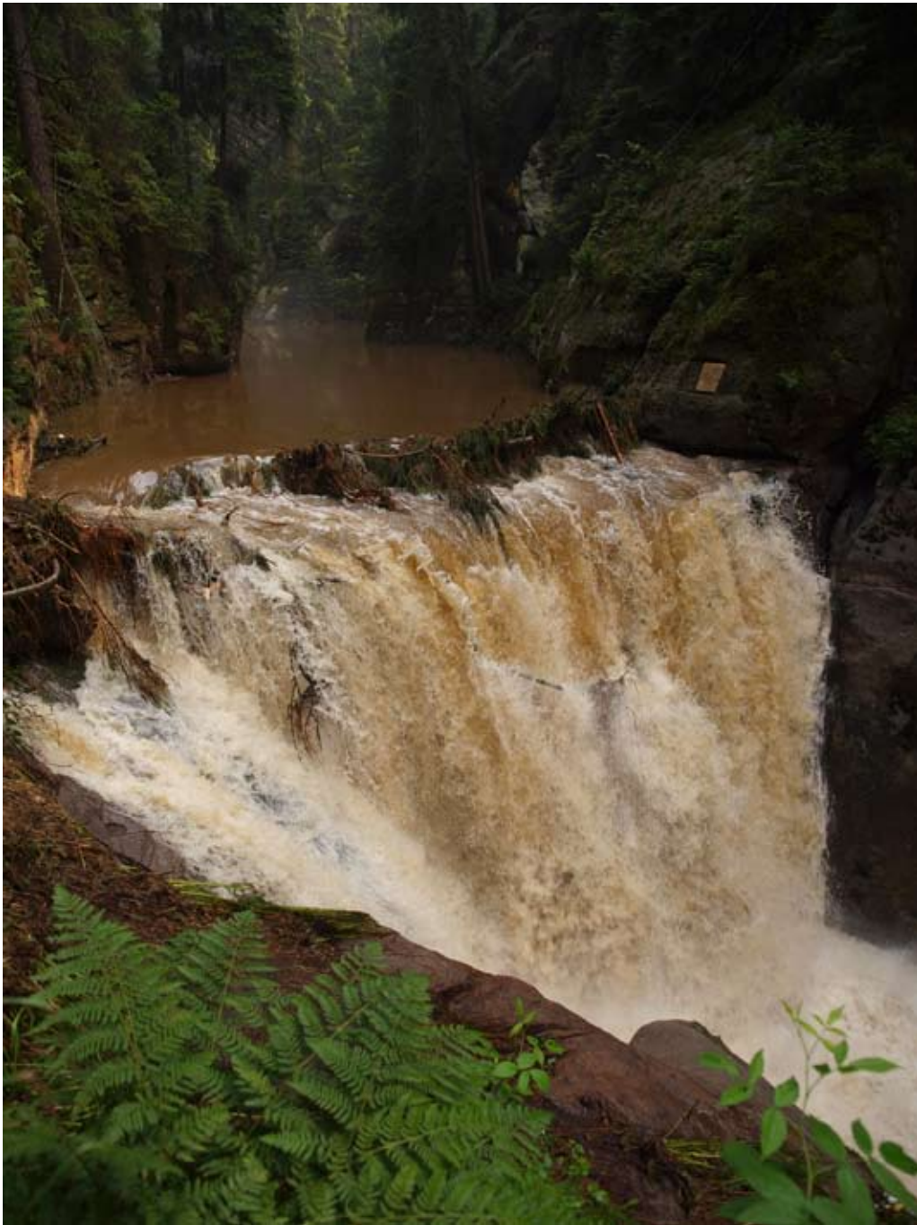
Staumauer Obere Schleuse am 8.8.2010 frühmorgens (Foto: Frank Strohbach, Hinterhermsdorf)
