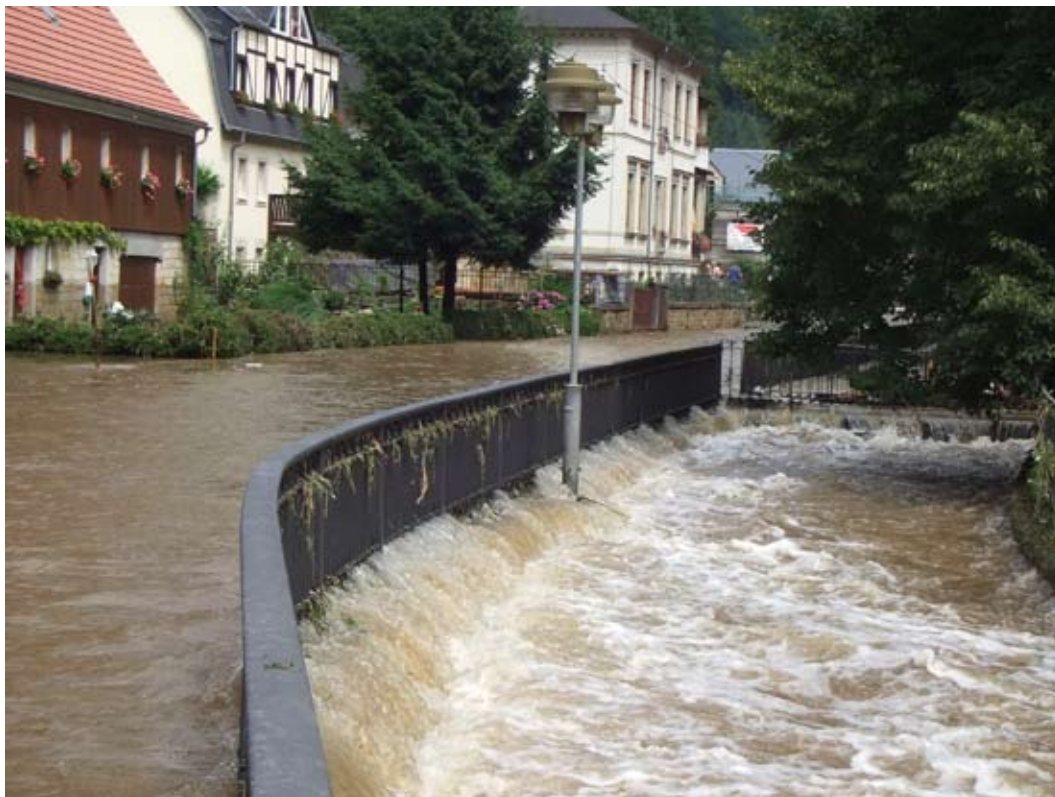
Alles unter Wasser an der Kirnitzsch in Bad Schandau. Es entstehen „Seitenwasserfälle“, denn das Wasser fließt im Bach schneller ab als auf der Straße. (Foto: Ekkert Fels, Dresden)
