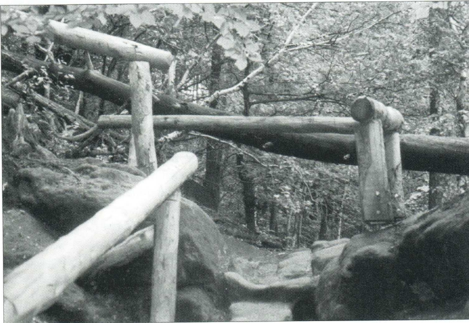
In den Felsuntergrund eingebaute Geländerpfähle in leichtem Gelände (Breite Kluft) Foto: R. Wobst
