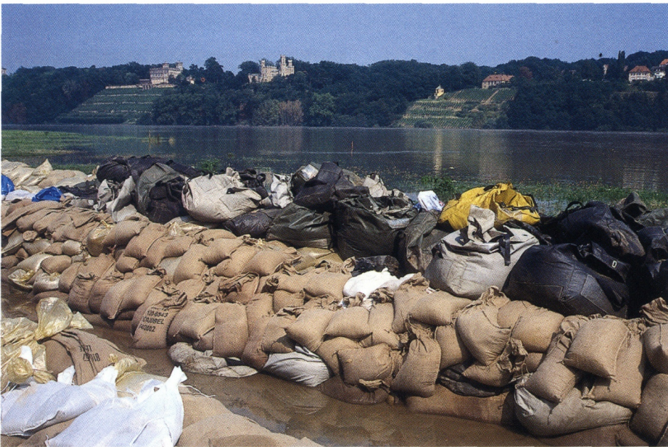
Mit Sandsäcken, wie hier am Käthe-Kollwitz-Ufer, versuchte man das Wasser der Elbe aufzuhalten. Der Fluß überflutete die von Bebauung freigehaltenen Elbwiesen zwischen Blasewitz und Johannstadt und machte zum Glück direkt vor der Uferstraße halt.
