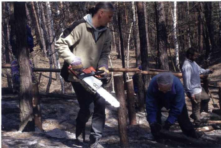
Beim Geländerbau kommt die Motorsäge zum Einsatz.
