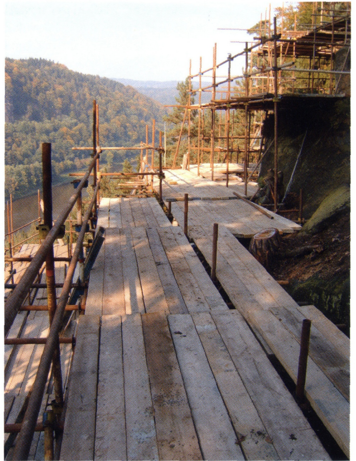
Aufwändig errichtetes Gerüst für Felssicherungsarbeiten am Goldenen Ranzen im böhmischen Elbtal Foto: Jens Brendel
