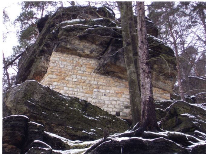
Sicherung eines Felsüberhangs bei Schmilka Foto: Jan Hänel
