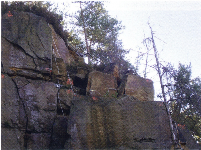
Beobachtung eines abrutschgefährdeten Sandsteinmassivs im böhmischen Elbtal (am Goldenen Ranzen – Nähe Belvedere) mittels Meßsonden Foto: Jan Hänel
