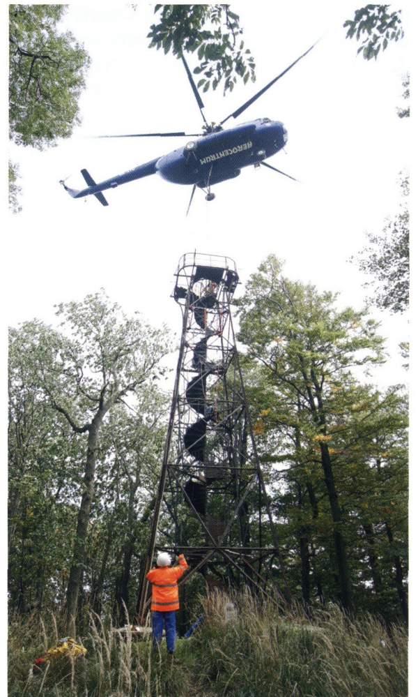
Der Turm auf dem Kaltenberg wird im September 2007 abtransportiert.
