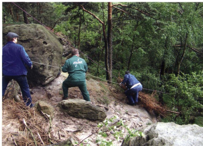
Faschinen werden per Flaschenzug bergauf transportiert.
