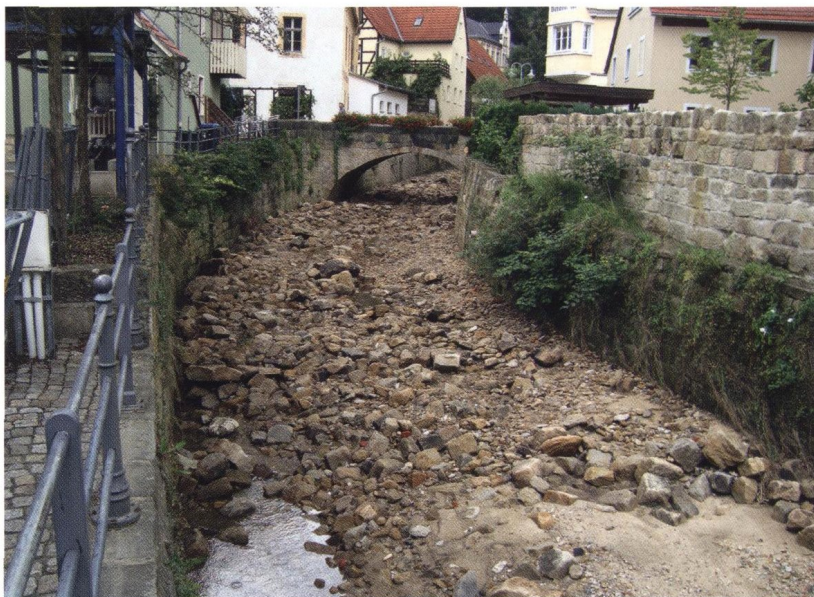
Ablagerungen von Steinen im Grundbach unmittelbar vor der Einmündung in die Elbe in Stadt Wehlen
