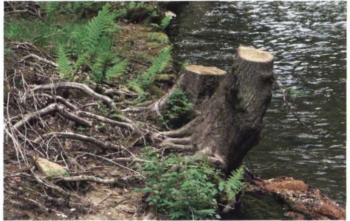
Noch stabilisiert das Wurzelwerk das Ufer ...
