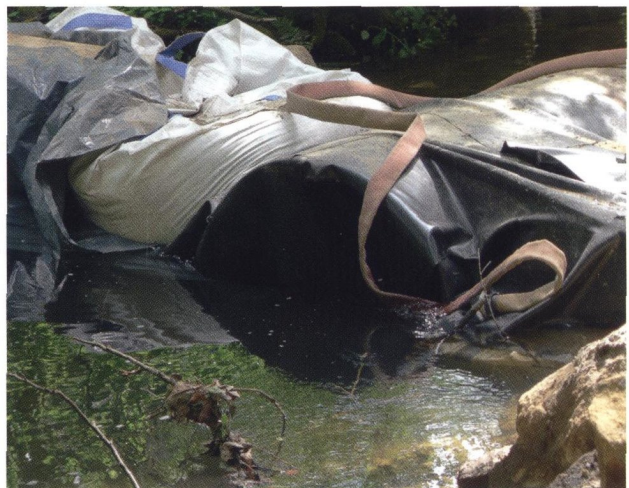
Bild 6: Damm an der Buschmühle, Eingang des Rohrs
