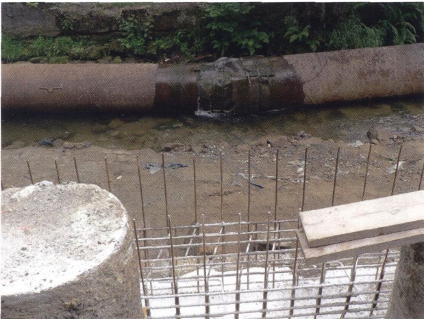
Bild 4: Provisorische Rohrverbindung
