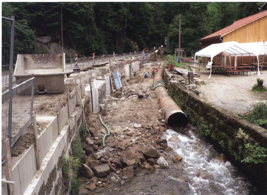
Bild 2: Bauen im Nationalpark; Gesamtansicht der Baustelle Buschmühle
