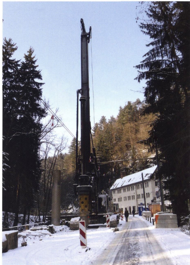
Bild 1: Schweres Bohrgerät am Beuthenfall
