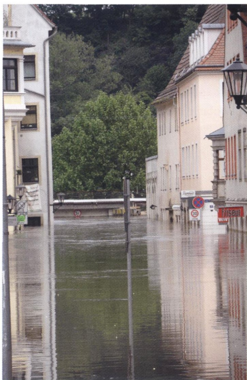
Blick durch eine Nebenstraße in Pirna zur Elbe zu einer gefluteten Eisenbahnunterführung
