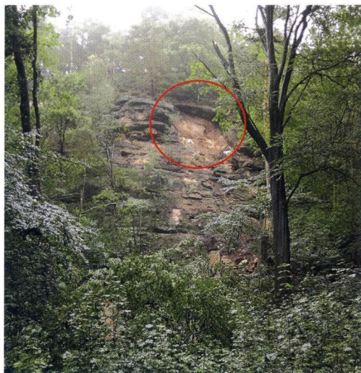
Die Ausbruchsstelle liegt weit oben in der Wand.
