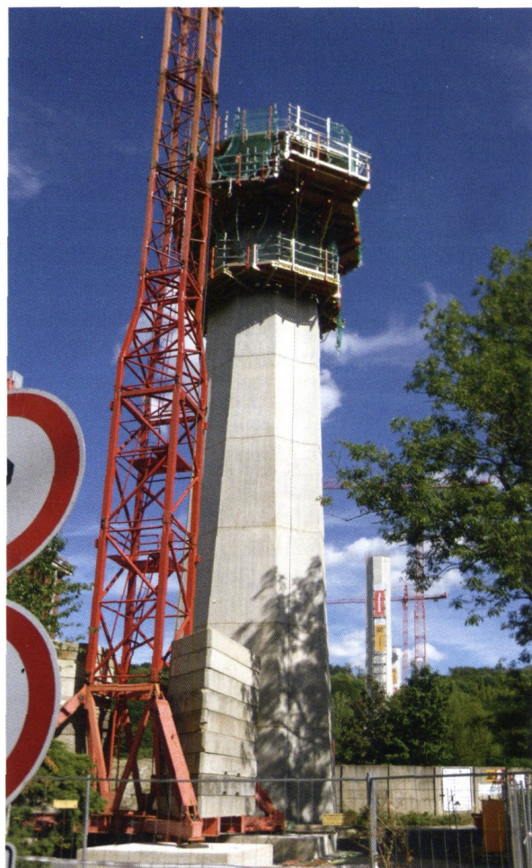
Pfeiler der Pirnaer Südumfahrung im Bau (2020)
